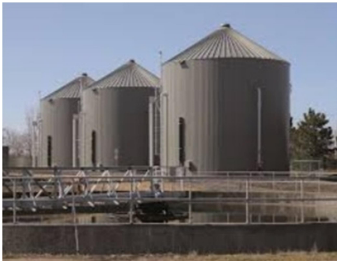
Fig: Anaerobic digestion prototype
